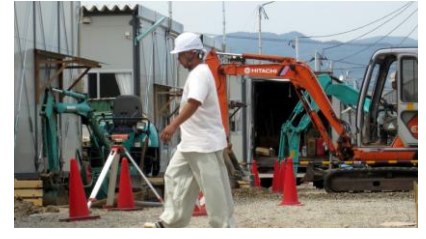
急ピッチで建設が進む避難者用仮設住宅 (福島市 2011.5.26 撮影)
